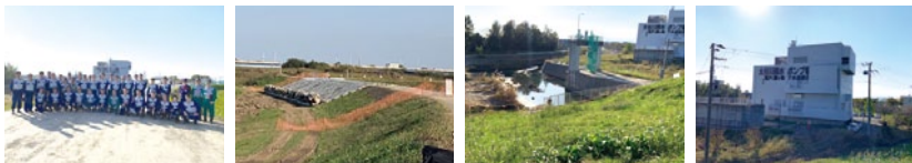
越辺川決壊箇所
