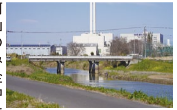
河川改修整備が進められている大利根地域の古門樋橋
