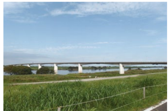
昭和47年に供用開始された埼玉大橋
