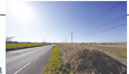
▲125号暫定2車線区間(工事発生土仮置き状況)
