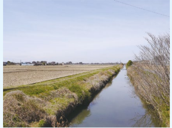
▲中川上流のかんがい排水事業(中川改修未整備区間)
