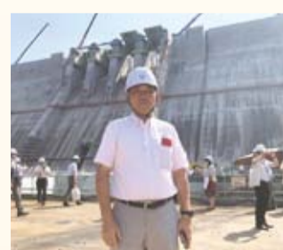
重力式コンクリートダム・高さ116m・総貯水容量10,750万㎡ 流域面積711.4km 2 ・工期:昭和42年度～令和元年度
